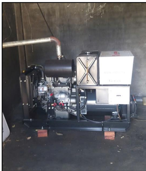
Hình 9. Phòng đặt máy phát điện và ống khói
